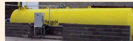
Abb. 1: Stationäre Pflanzenöl-EVT 30 Kubikmeter
